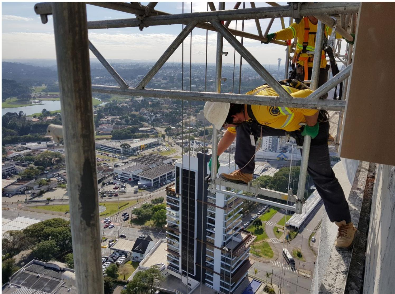
Tivemos um pouco de dificuldades, devido a altura e ao tamanho das treliças que foram conectadas para que atendessem o comprimento necessário de aproximadamente 12,00m. Lembrando que as conexões de treliças são feitas conforme manual de montagem e instruções do fabricante de andaimes”, completa Gean.
